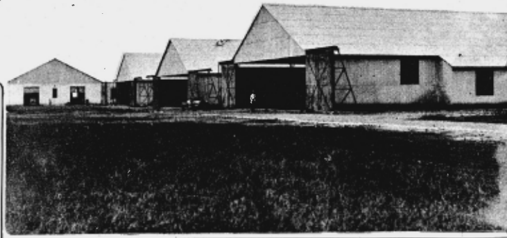
Hangares existentes en el campamento de Columbia.
